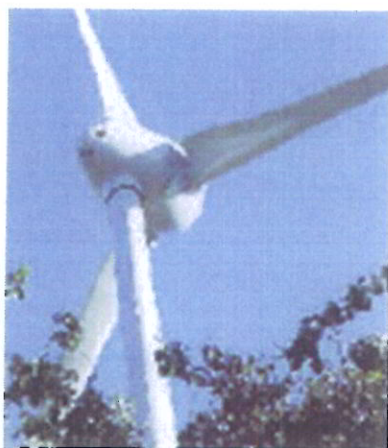
L'impianto a Pian dei Corsi
